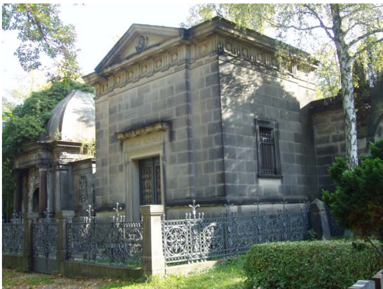
Mausoleum Rohmer nach der Restaurierung
